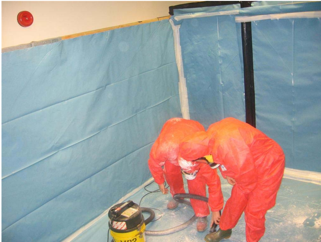
Figura 7.1 Exercícios práticos de utilização de aspiradores de tipo H para remover contaminantes simulados (pó de talco). Fotografia cedida pelo HSE do Reino Unido.
