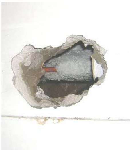
Figura 4.4 Abertura numa parede pondo a descoberto um tubo com isolamento de amianto.
