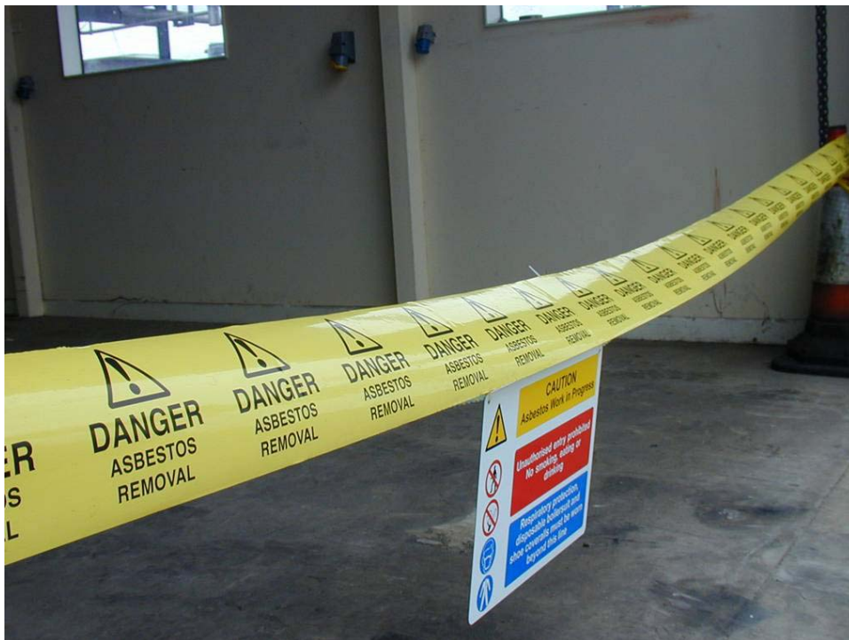
Figura 11.1 Utilização de fita (com a menção «Perigo Remoção de Amianto» e sinais de aviso para delimitar a zona).
