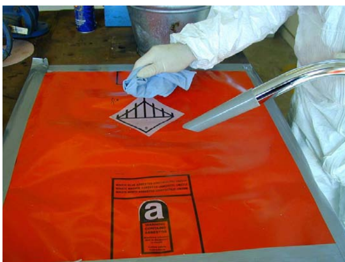
Figura 11.7 Limpeza meticulosa da zona de trabalho com um aspirador de tipo H e trapos húmidos.
