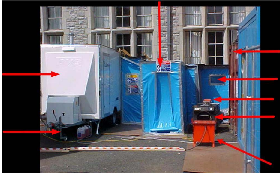
Figura 12.1 Entrada numa zona confinada podendo ver-se, no sentido dos ponteiros do relógio, começando no topo, a câmara para sacos, o contentor de resíduos, a janela, o aparelho de registo da pressão negativa, a unidade de pressão negativa, a unidade de abastecimento de energia eléctrica, o stock de agente molhante e a unidade de descontaminação.
