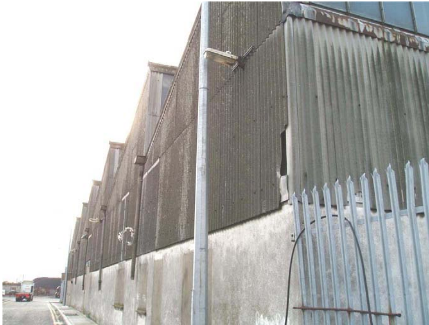
Figura 4.10 Revestimento de fibrocimento numa fábrica.
