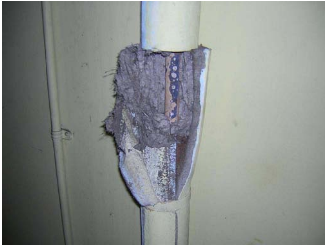
Figura 12.7 Isolamento de uma conduta com camadas múltiplas de amianto e penetração do agente molhante.
