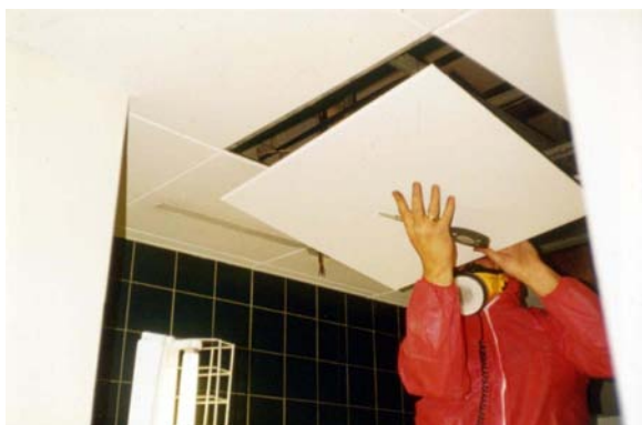
Figura 12.13 Remoção cuidadosa de uma placa de amianto.
