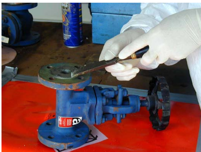
Figura 11.5 Utilização de ferramentas exclusivamente manuais para limpar juntas e resíduos de uma válvula.
