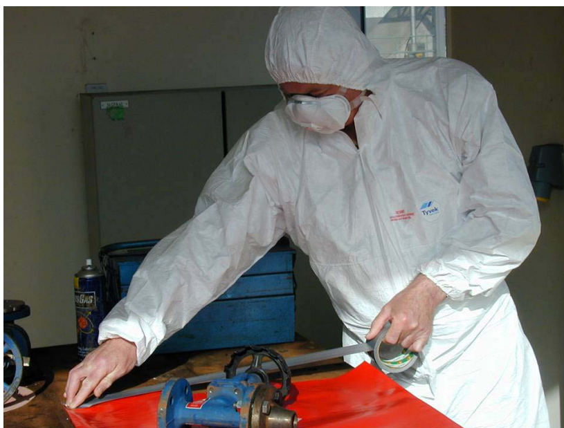
Figura 11.3 Utilização de fita e de folha de polietileno para proteger a zona de trabalho previamente à limpeza das juntas de amianto de uma válvula.
