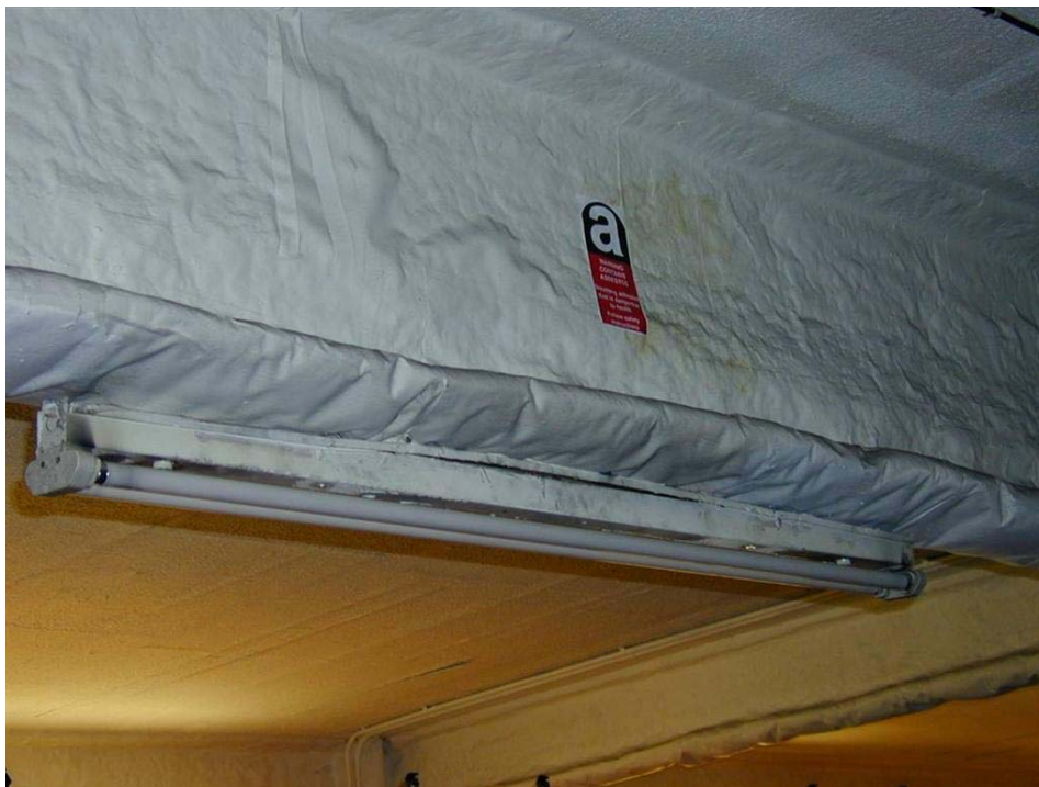
Figura 4.11 Estruturas de aço com isolamento de amianto.
