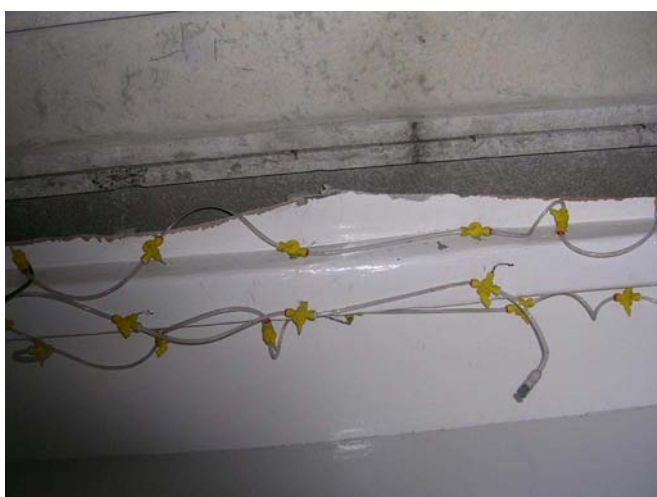
Figura 12.9 O sistema de injeção com escoamento de água a partir dos vários orifícios de cada agulha. Fotografia cedida pelo HSE do Reino Unido, extraída do manual HSG 274. © Crown. Material reproduzido com autorização do director da HMSO (Her Majesty's Stationery Office) e do Office of the Queen's Printer for Scotland.
