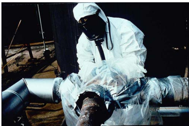
Figura 12.12 Sacos de luvas utilizados na remoção controlada de guarnições de amianto (fotografia cedida pelo INRS, direitos de autor INRS).
