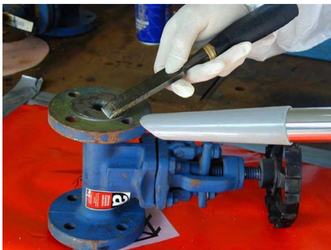
Figura 11.6 Utilização da aspiração simultânea para captar as poeiras que se libertam ao limpar o amianto de uma válvula.
